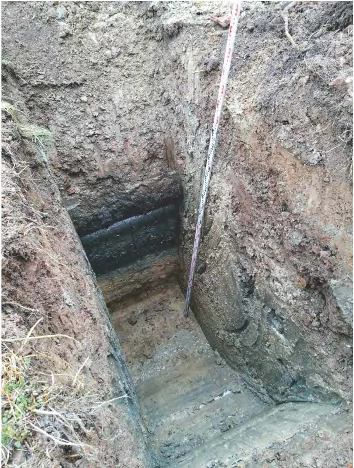
Fotodokumentation des Schurfs SCH 7
